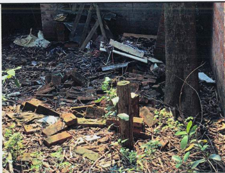
污水处理设施
