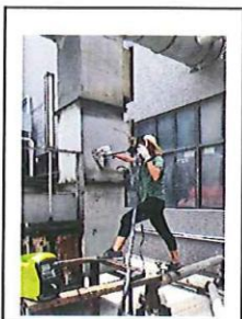
搅拌、理布工序废气处理前
