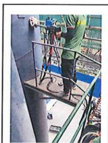
压延、贴合工序 废气处理后
