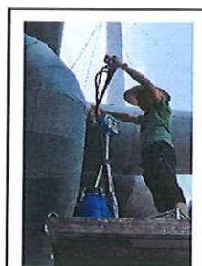
1#发泡工序废气处理前
