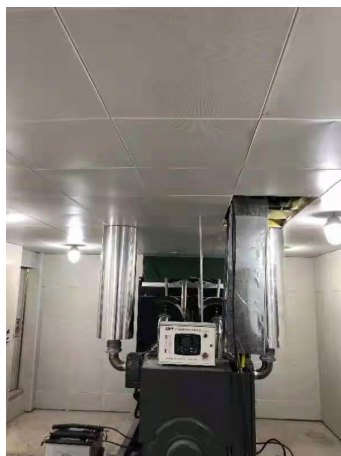
图 5 发电机排气筒
