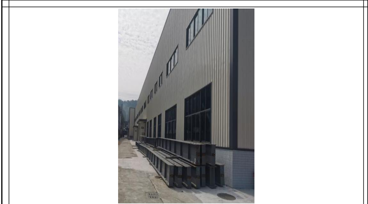
1#厂房 A 现状及厂区内道路
