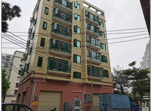
图片 2 项目南侧情况
