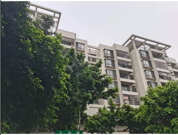
图片 1 项目东侧情况
