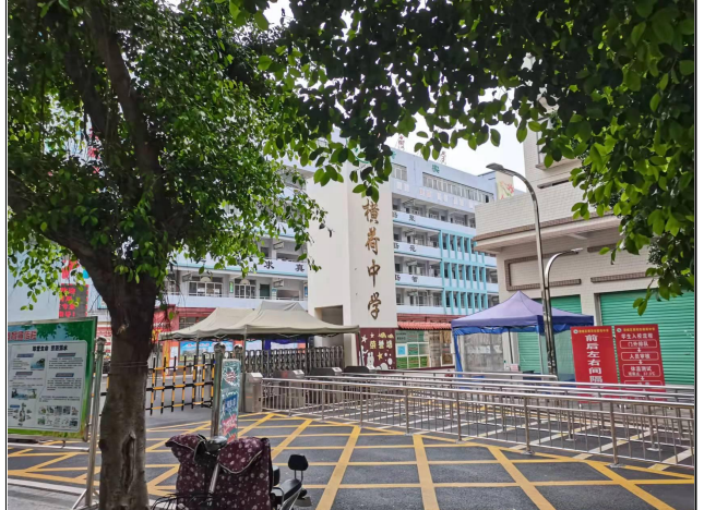
图片 4 项目北侧现状
