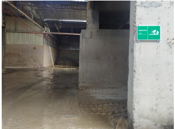
图 2 一般固废贮存场所
