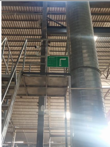
图 5 P1 破碎粉尘排放口 (DA001)、采样平台及标识牌
