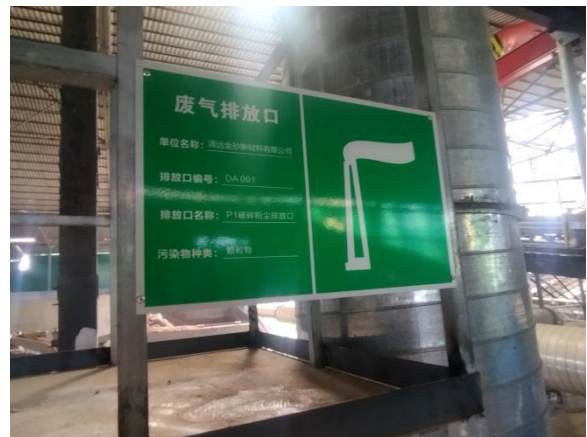
图 5 P1 破碎粉尘排放口 (DA001)、采样平台及标识牌
