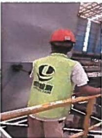
烘干系统燃烧烟气 P6-1 排放口
