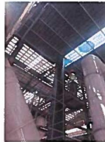
蒸汽发生器燃烧烟气 P5 排放口
