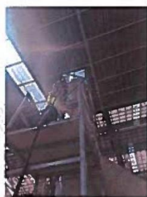
酸洗工序 P4 排放口
