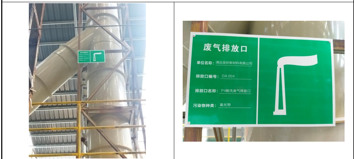
图 8 P4 酸洗废气排放口 (DA004) 及其标识牌
