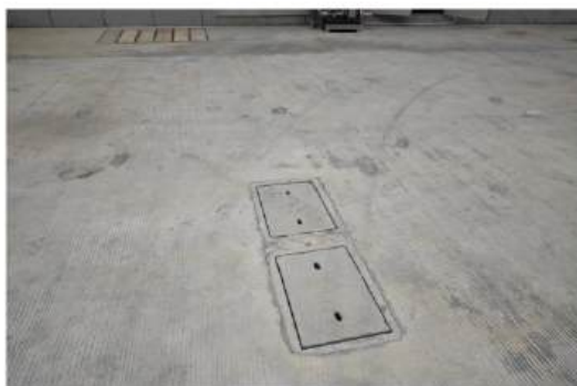
事故应急池（埋地）
