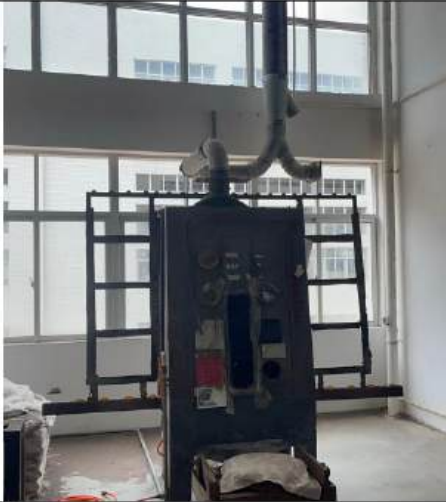
玻璃磨砂粉尘经喷砂机密闭收集
