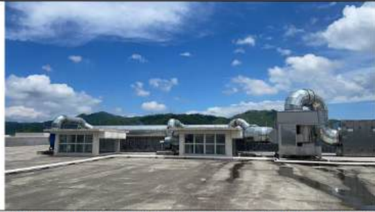
涂装有机废气高效旋流柜+干式过滤+活性炭吸附浓缩+催化燃烧（CO）
