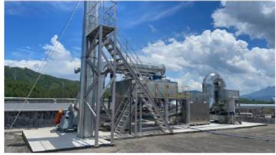
浸渍线、压板线有机废气高效旋流柜+干式过滤+活性炭吸附浓缩+催化燃烧（CO）处理
